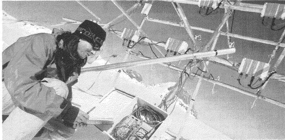
Ein Forscher der ETH Lausanne installiert einen Schall-Windmesser.
